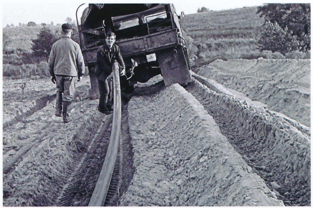
Fot 7. Układanie kolejnej 48 metrowej sekcji rur PE wzdłuż wykopu. Fot. Jerzy Jan Czopek
