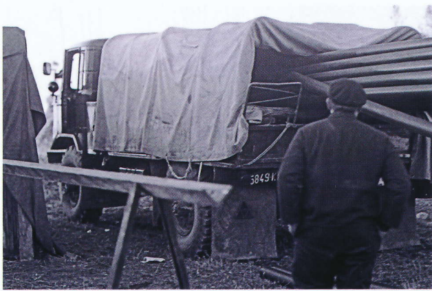
Fot 6. Wiązka sekcji 48 metrowych zamocowana na „Starze 66”, przygotowana do przeciągania. Fot. Jerzy Jan Czopek
