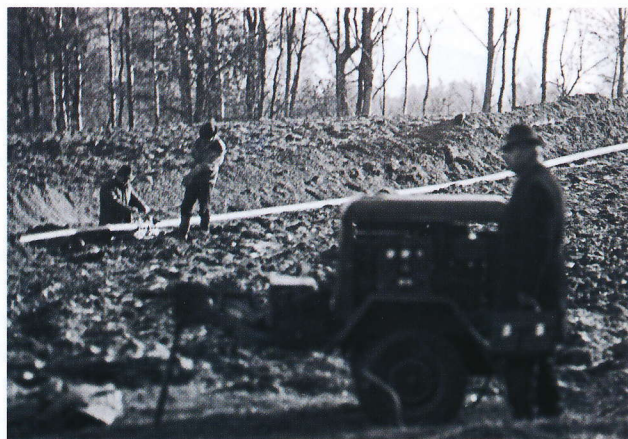
Fot 11. Przygotowania do próby szczelności. Fot. Jerzy Jan Czopek
