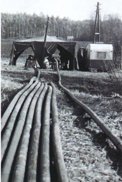
Fot 4. Półstacjonarne, stanowisko do zgrzewania na trasie gazociągu. Zgrzewarkami typu Mansfeld łączono tu 12 metrowe odcinki rur PE (przywożone z gazowni w Szczecinku), w sekcje 48 metrowe. W miarę postępu prac, stanowisko było przemieszczane wzdłuż trasy gazociągu. Fot. Jerzy Jan Czopek
