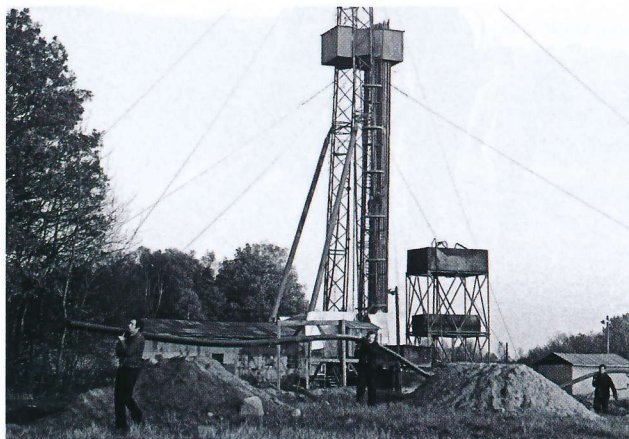
Fot 10. Układanie sekcji rur wzdłuż wykopu. Fot. Jerzy Jan Czopek
