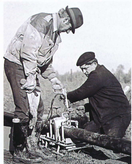
Fot 9. Łączenie prototypową zgrzewarką ręczną w gazociąg, 48 metrowych odcinków rur PE ułożonych wzdłuż wykopu. Fot. Jerzy Jan Czopek
