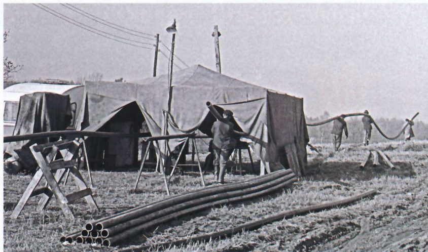
Fot 5. Przeszwanie rury PE w celu zgrzania kolejnego odcinka 12 metrowego. Fot. Jerzy Jan Czopek
