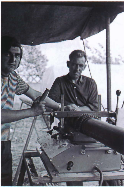
Fot 3. Stacjonarne zadaszone stanowisko do zgrzewania rur PE na terenie gazowni w Szczecinku. Zgrzewarką typu Mansfeld produkcji NRD łączono 6 metrowe rury PE w odcinki 12 metrowe. Fot. Jerzy Jan Czopek
