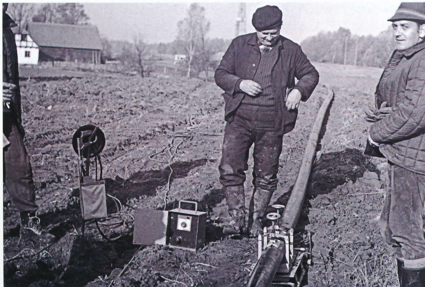
Fot 8. Mobilne, prototypowe stanowisko do zgrzewania, zaprojektowane i wykonane w Instytucie Gazownictwa. Fot. Jerzy Jan Czopek
