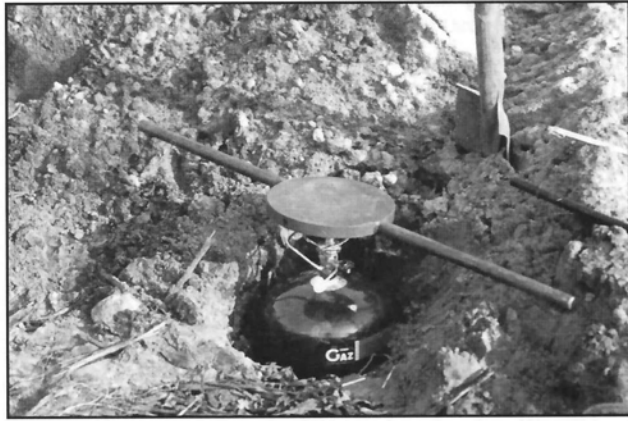
Fot 3. Płyta stalowa podgrzewana gazem płynnym.
