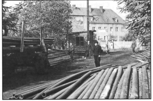
Fot 4. Główny magazyn rur polietylenowych na terenie gazowni w Szczecinku.
