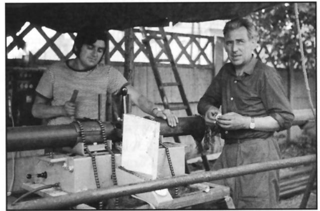
Fot 5. Stacjonarne zadaszone stanowisko do zgrzewania na terenie gazowni w Szczecinku.
